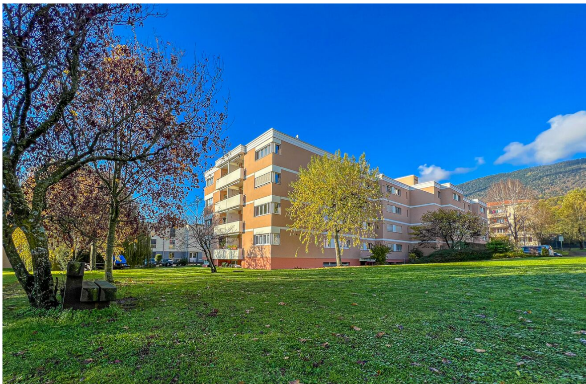
Vue sur le bâtiment
