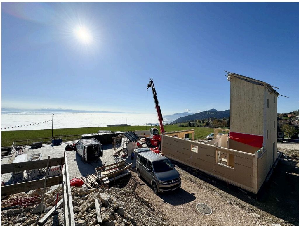
Vue sur le bâtiment A
