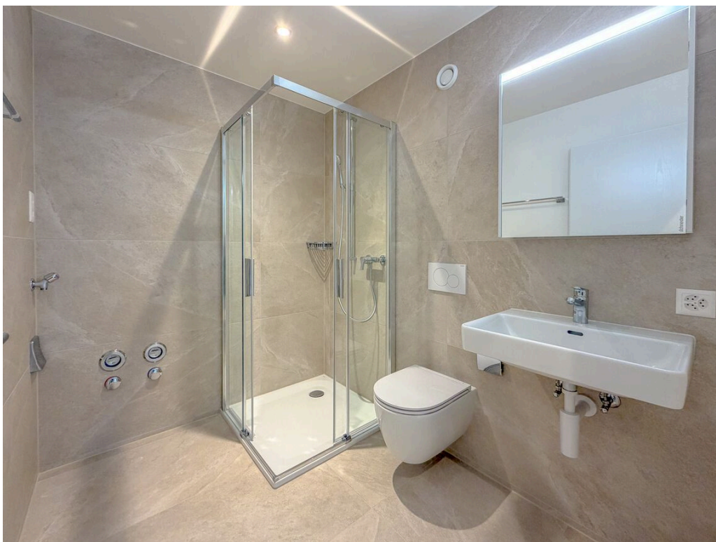
Salle d'eau avec pré-équipement pour une colonne de lavage
