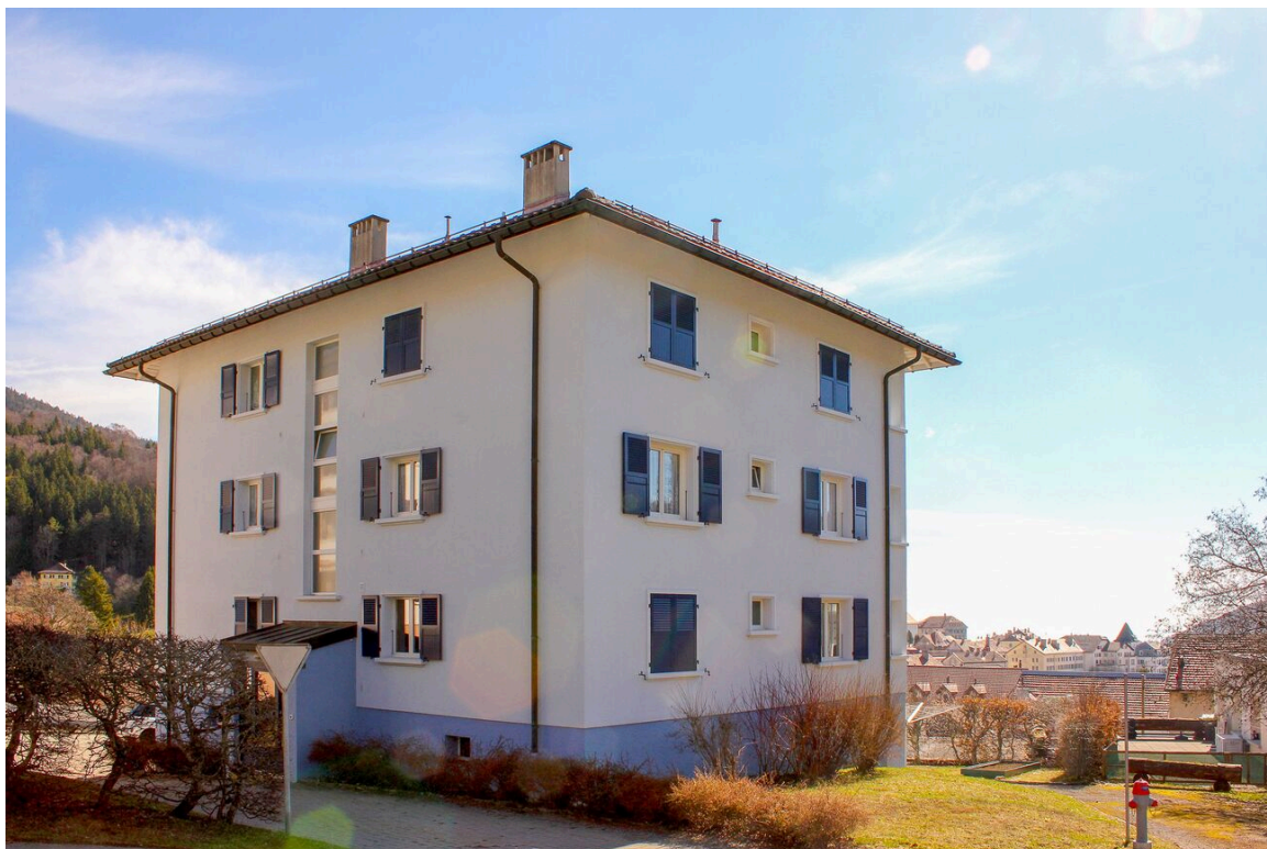
Vue sur le bâtiment PPE
