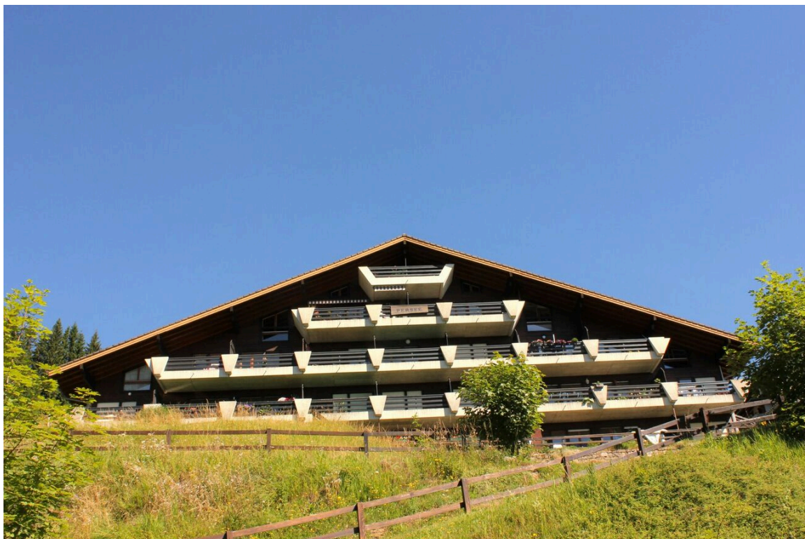
Vue sur le bâtiment Persée
