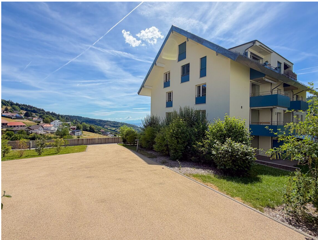
Vue sur le bâtiment Lac
