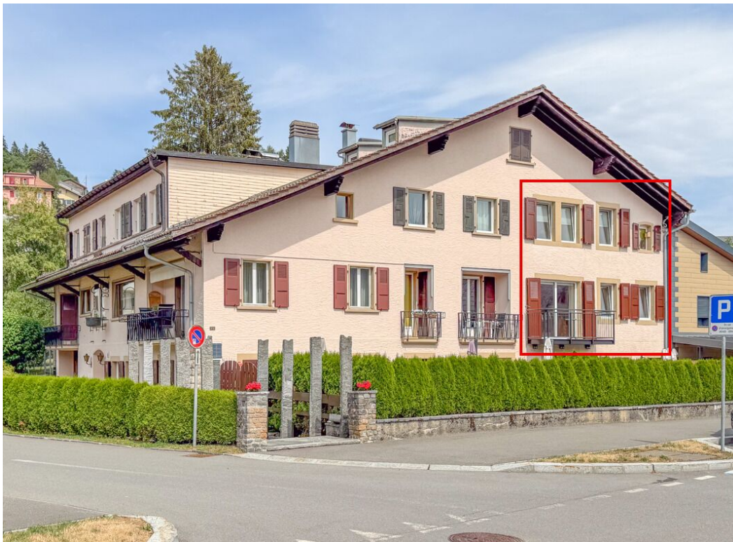
Vue sur le bâtiment
