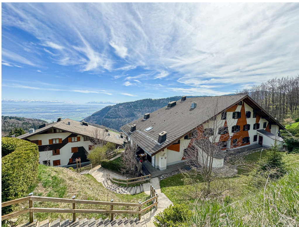
Vue sur le bâtiment Persée
