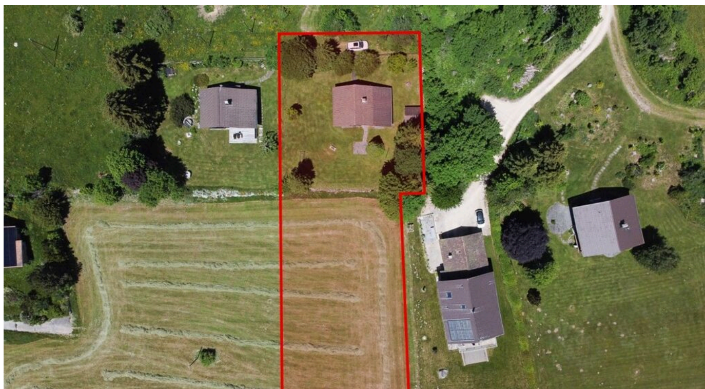
Vue aérienne d'une partie de la parcelle
