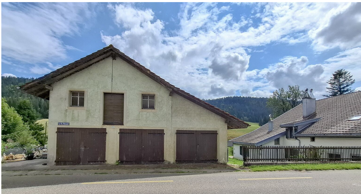
Maison attenante avec 3 garages indépendants
