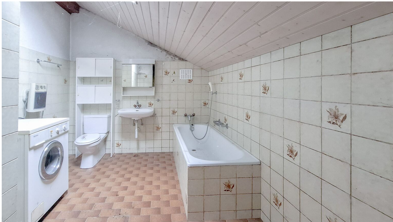
Salle d'eau au rez supérieur
