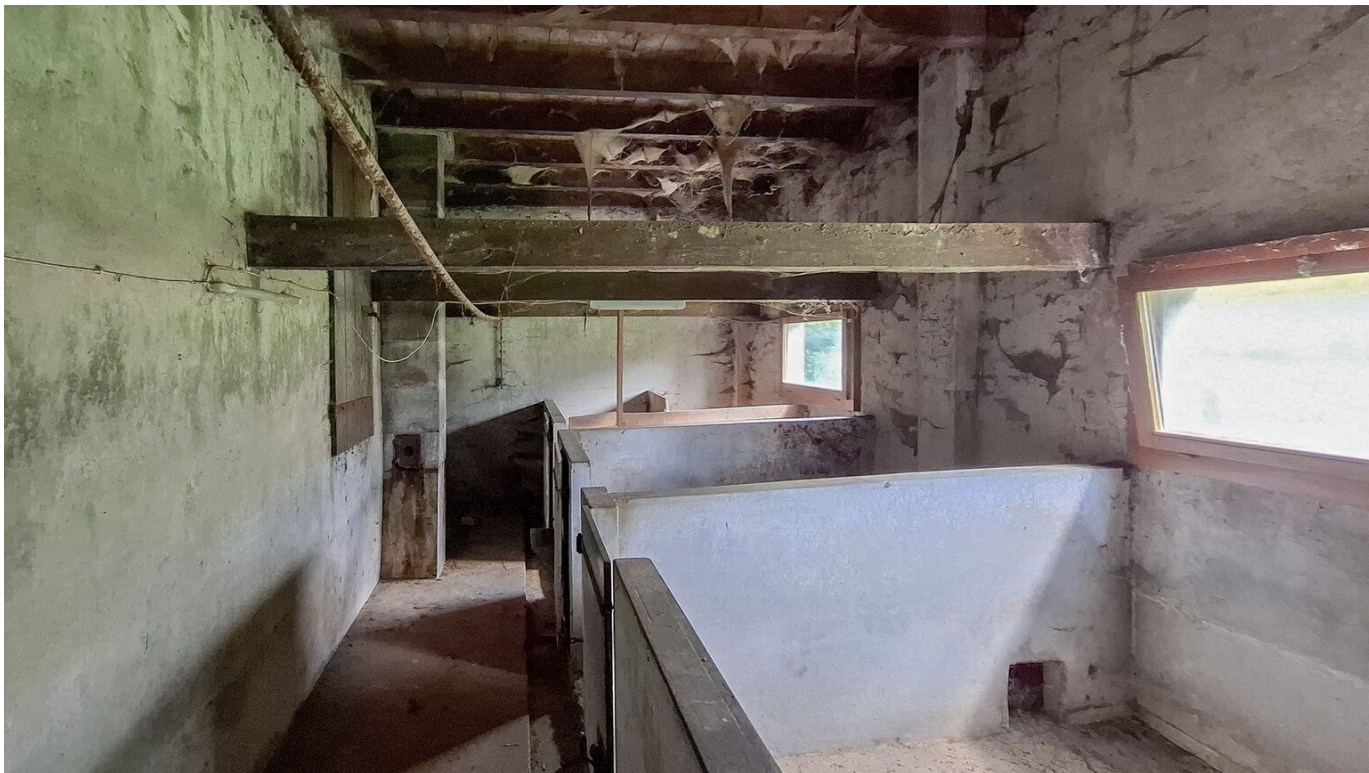
Maison attenante au rez inférieur - ancienne porcherie avec belle hauteur sous-plafond
