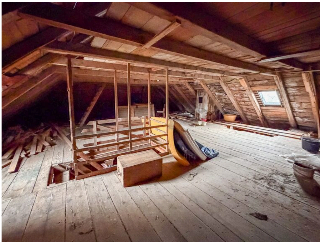
Immeuble - Combles et surcombles
