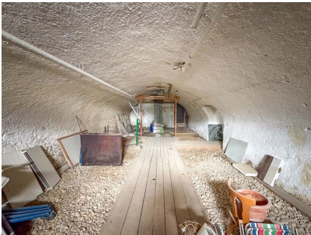
Immeuble - Sous-sol - cave voutée
