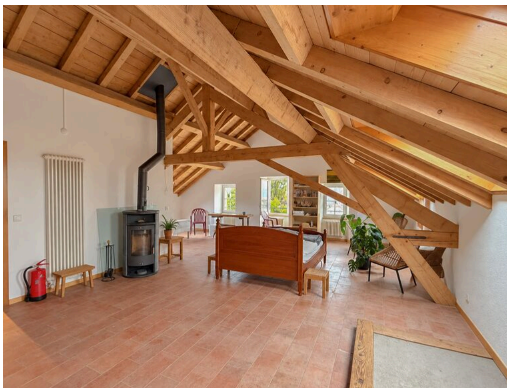
Combles - grand espace ouvert de 80 m 2
