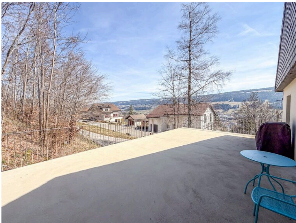
1er étage - Grande terrasse sur le double garage
