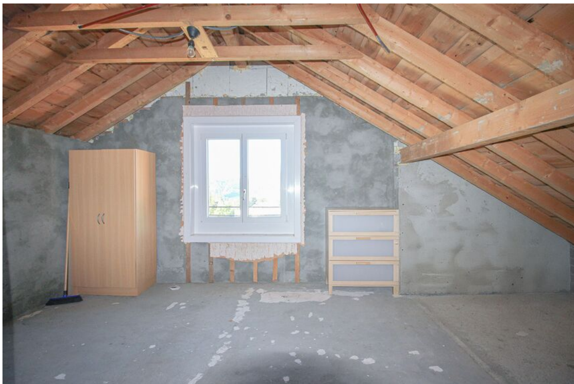
Combles à aménager
