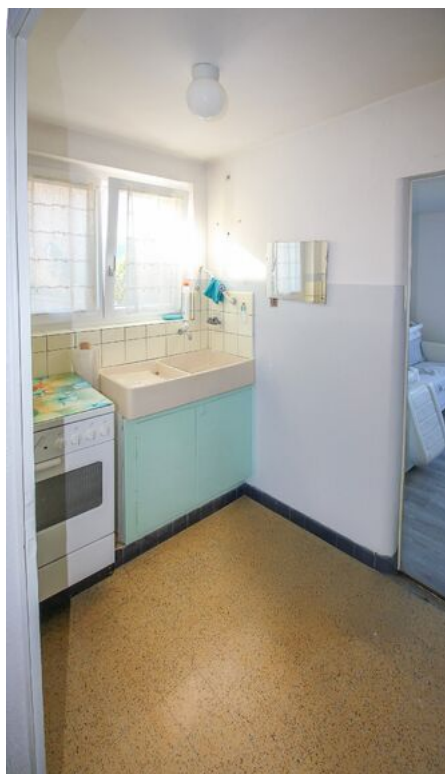
Rez inférieur - cuisine à rénover
