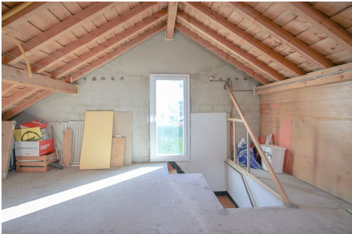
Combles à aménager
