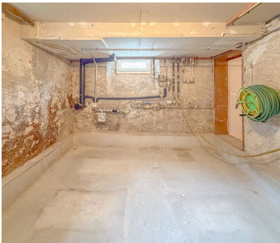
Rez inférieur, ancien local citerne
