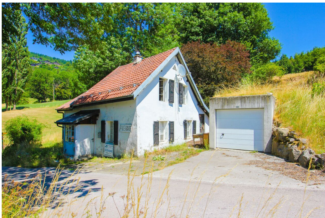
Vue sur la maison et le garage
