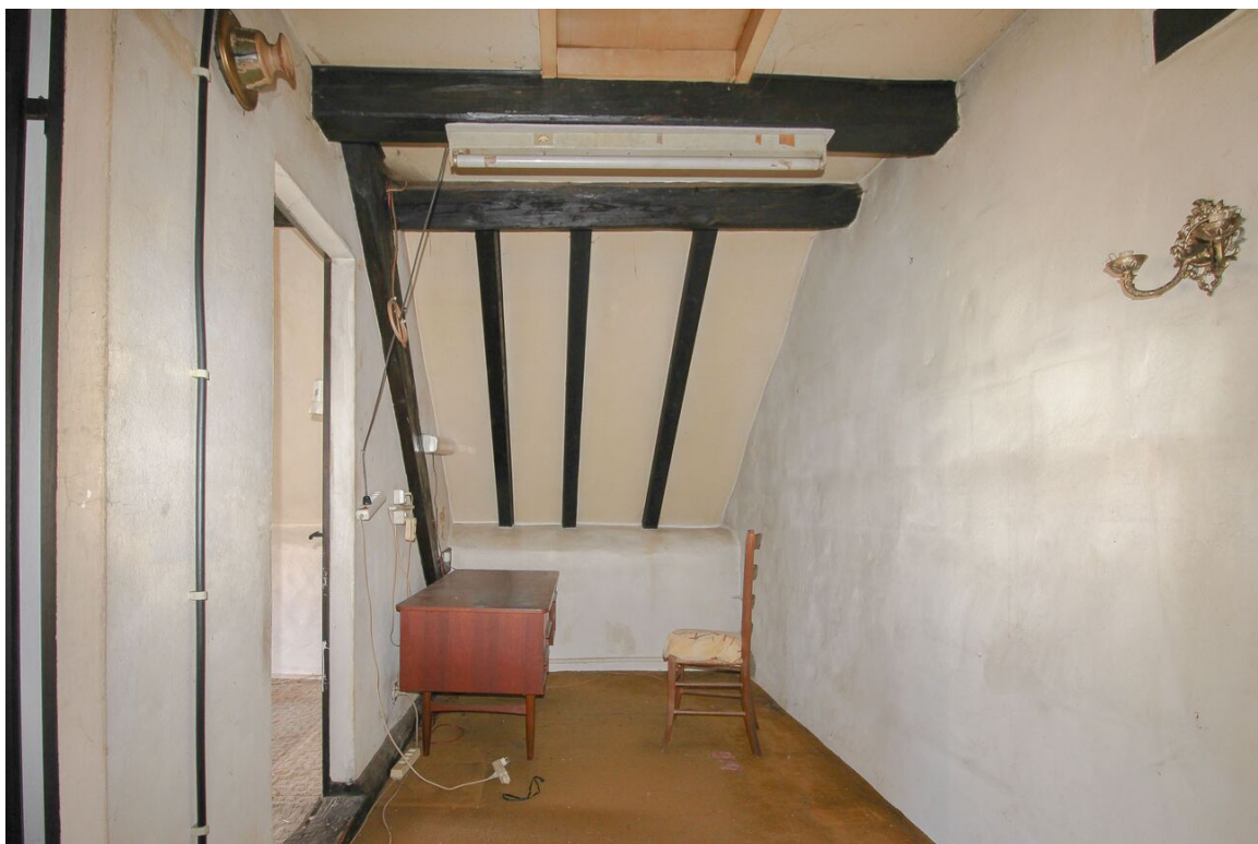
Couloir de distribution à l'étage
