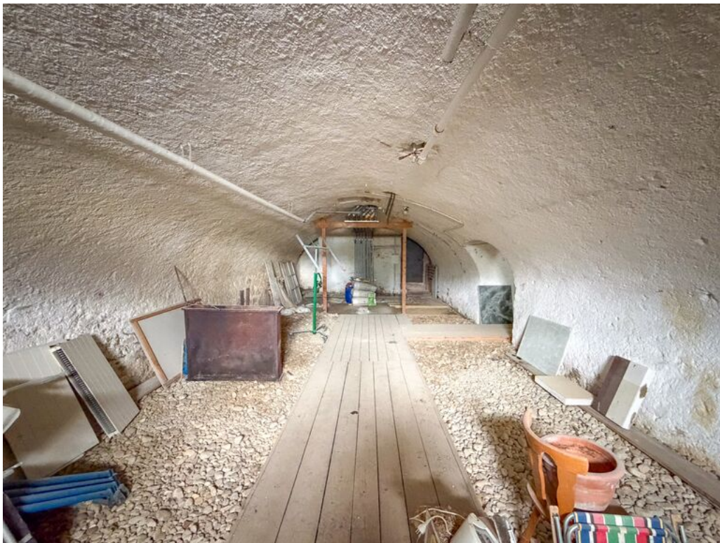
Immeuble - Sous-sol - cave voutée
