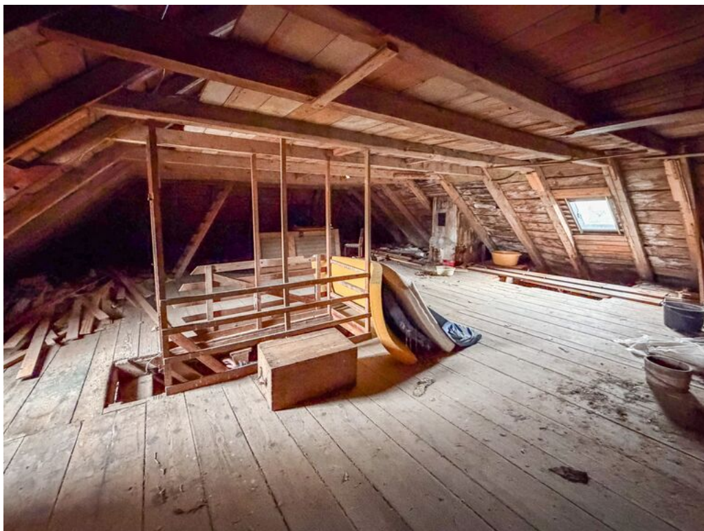
Immeuble - Combles et surcombles
