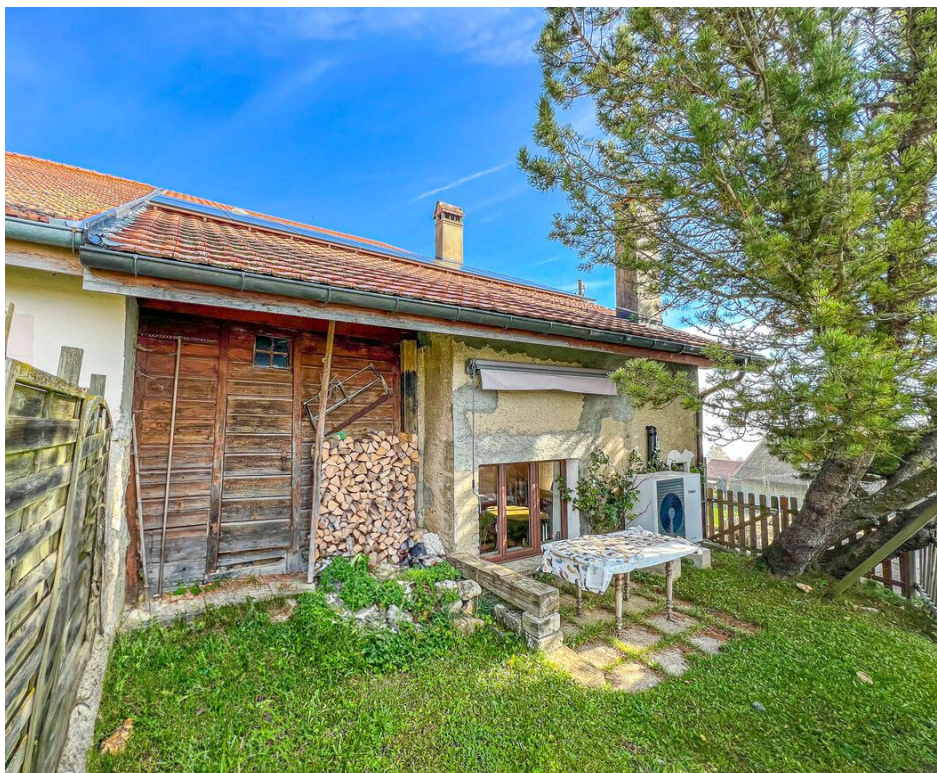
Accès au rural par l'Ouest + terrasse
