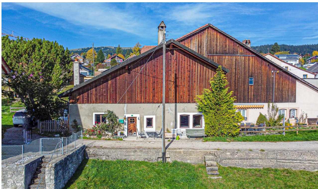
Vue aérienne façade Sud
