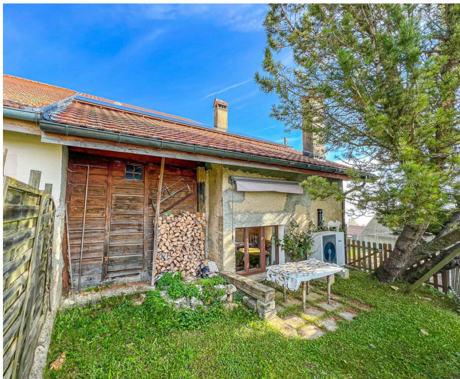
Accès au rural par l'Ouest + terrasse
