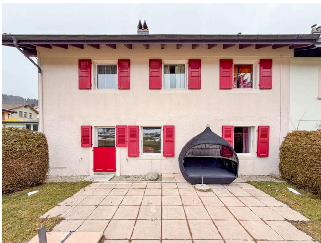
Vue extérieure Sud
