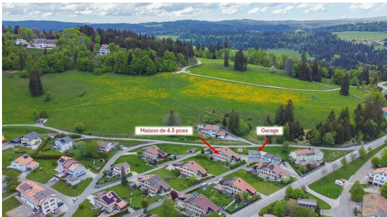
Vue aérienne sur la maison et le garage en sus
